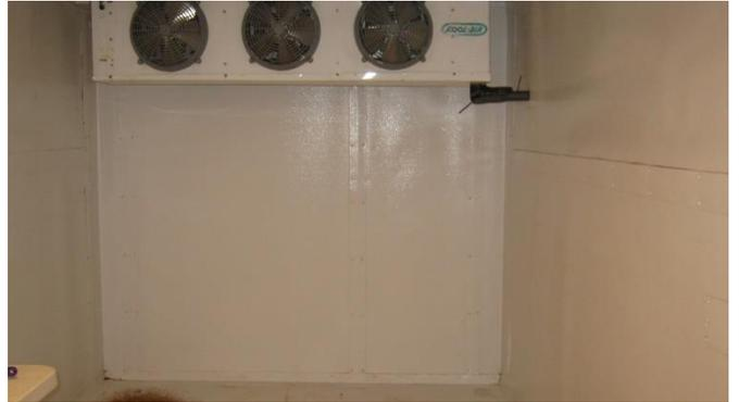
J'ai fabriqué une petite structure en aluminium et utilisé des panneaux en plastique Hi-core. →
